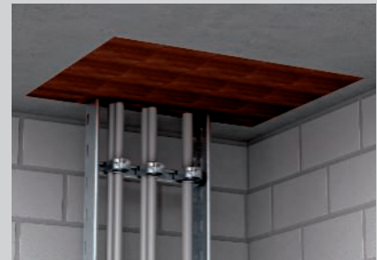
Strammsitzender Einbau der Blöcke im Deckendurchbruch.
