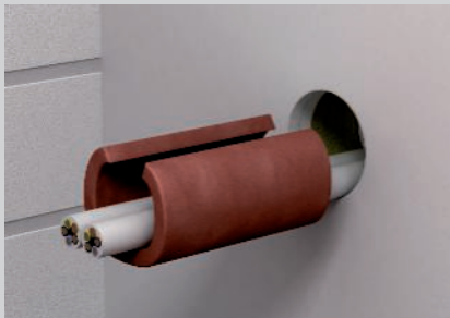
Bei bereits installierten Kabeln Aufschneiden der Rohrschale.
