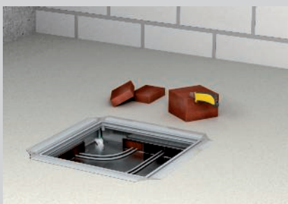
Schmale Streifen für die Kanalzüge zuschneiden.
