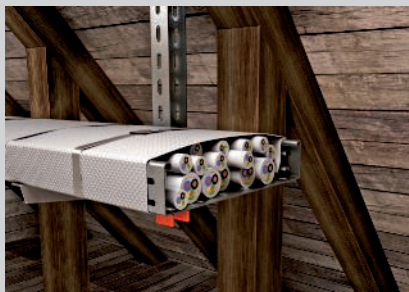
Bandagierte Kabeltragsysteme in Bereichen mit sehr viel brennbaren Materialien.
