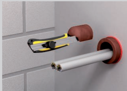
Zuschneiden und Einsetzen der Stopfen in die Rohrschale.
