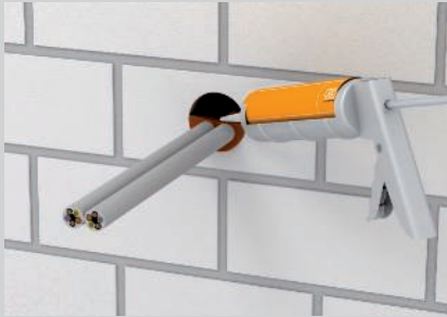
Verschließen der Öffnung mit der Spachtelmasse FBA-SP.
