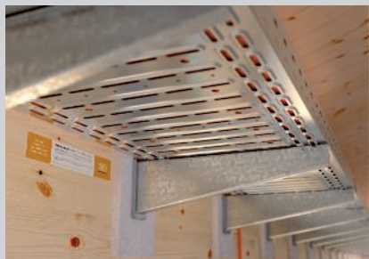
Auslegermontage seitlich am Holzbalken mit hinterlegter Brandschutzplatte.
