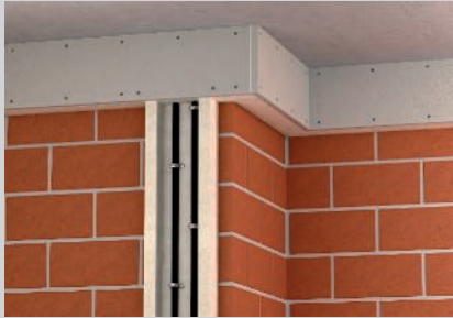
Kabelbefestigung bei senkrechter Kanalmontage mit Schellen.
