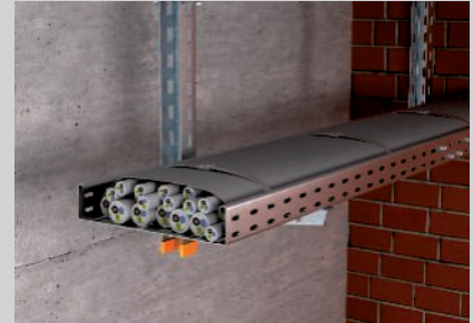
Bandagierung der Kabelbündel auf Tragsystemen.
