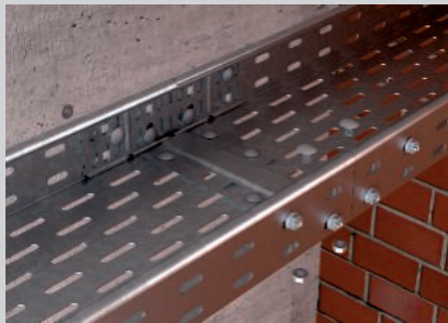
Längsverbinder und Stoßstellenleiste mit Flachrundschrauben befestigen.
