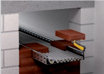
Montage der zugeschnittenen Blöcke.
