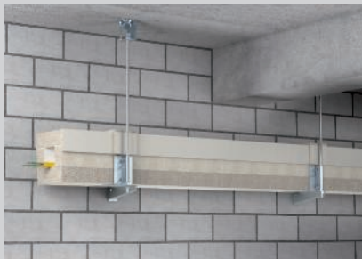
Wandmontage auf Auslgern und zusätzlicher Gewindestangesicherung.
