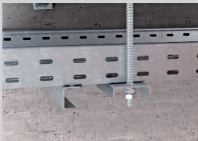
Befestigung der senkrechten Gewindestange an der untersten Kabelrinne.
