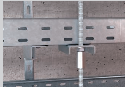
Gewindestangenbefestigung an der Rinne bei mehrlagiger Anordnung.
