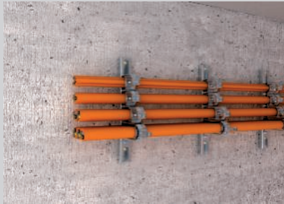
Waagerechte Montage der Kabel mit Bügelchellen an der Wand.
