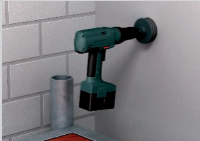
Bohren eines Lochs mit einem Dosenbohrer.
