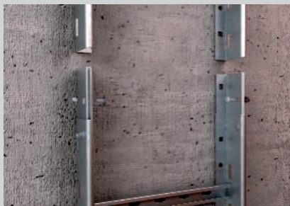
Stoßstellenverbindung mit verschraubtem Verbinder.
