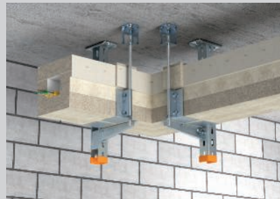
Abgehängte Deckenmontage mit zusätzlicher Gewindestangesicherung.
