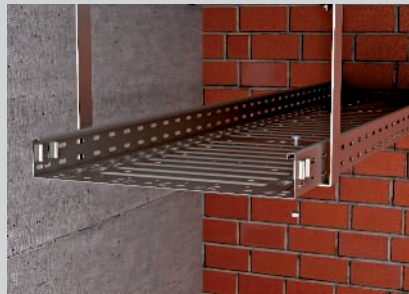
Befestigung der Kabelrinne mit Flachrundschauben.
