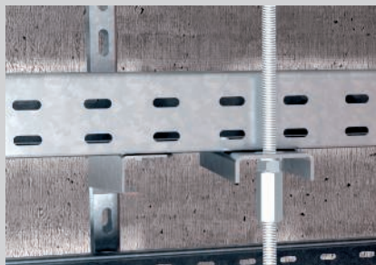
Gewindestangenbefestigung an der Kabelrinne bei mehrlagiger Anordnung.
