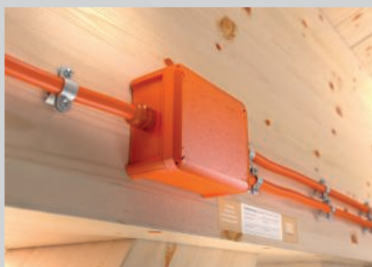
Montage der OBO FireBox am Holzbalken.
