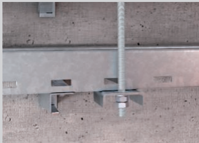
Befestigung der senkrechten Gewindestange am Anschlussbauteil.
