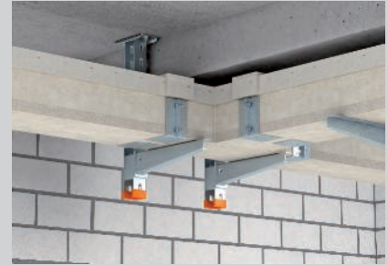
Vormontierte Standardformteile im Trassenverlauf.
