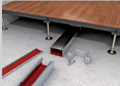
Montage auf Rohbeton im Systemboden.
