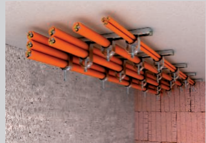
Waagerechte Montage der Kabel mit Bügelchellen unter der Decke.
