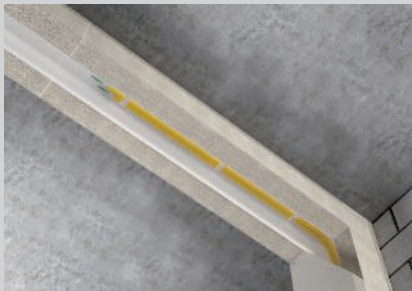
Direkte Wand- und Deckenmontage.
