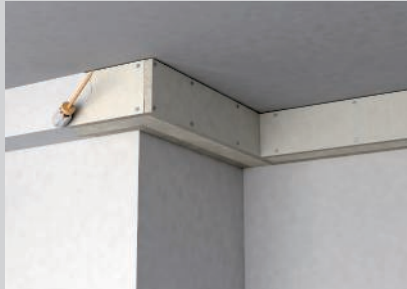
Abschließende Oberflächenbehandlung durch Streichen oder Tappeziieren.
